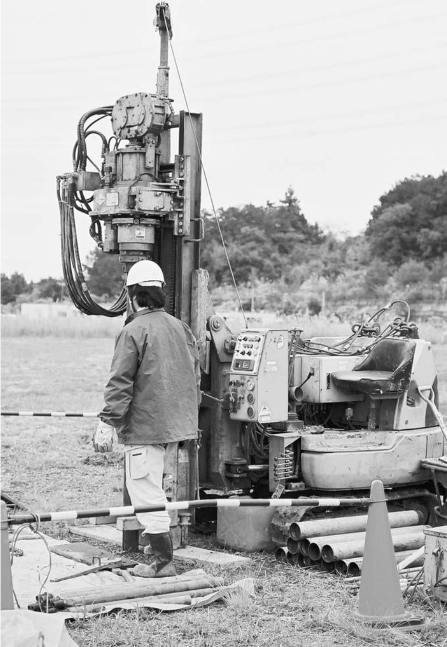
土壌汚染調査で活躍するボーリングマシン「エコプローブ」
