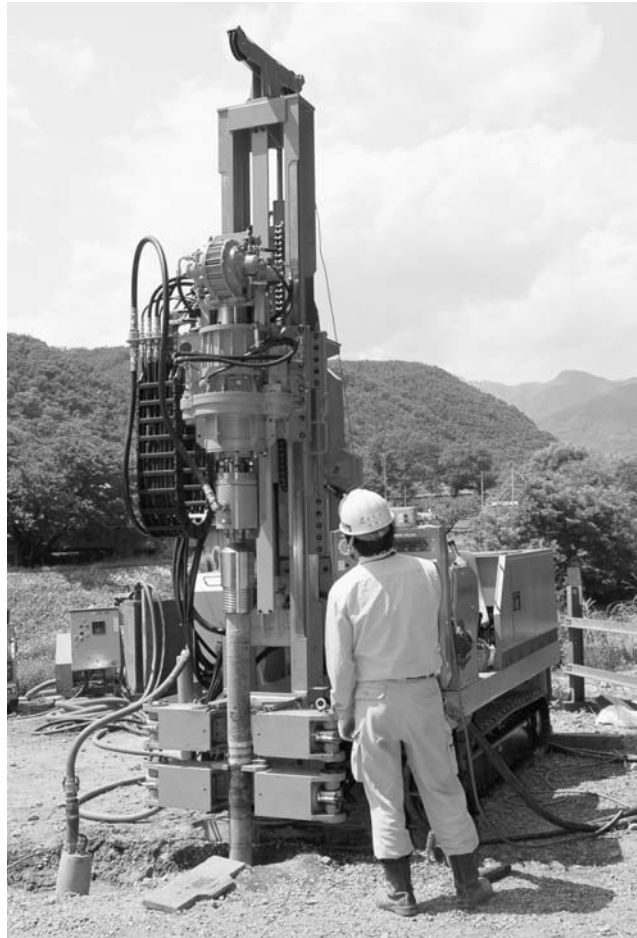
試験掘削しているEP-55プロトタイプ機(東亜利根ボーリング塩山工場にて)
